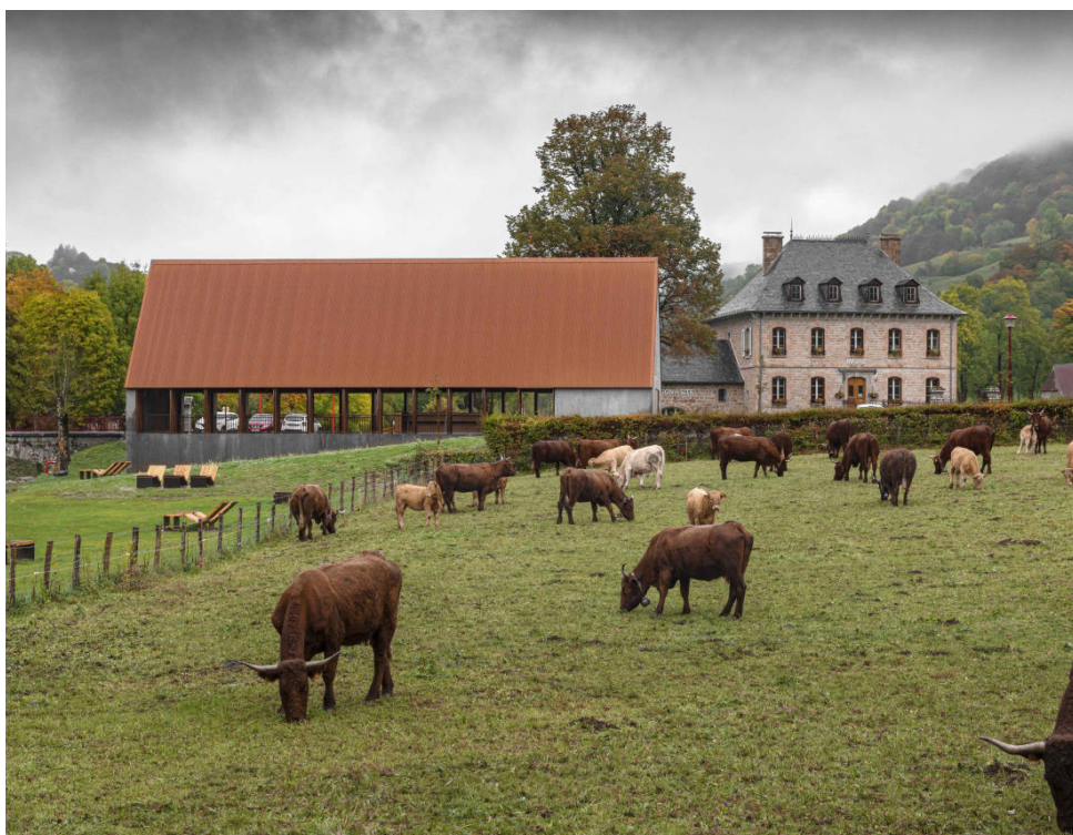
cf : Eco pâturage ; station de plaine nature Architecte : Simon Teyssou et associés ; Mandaille Saint Julien (15)
