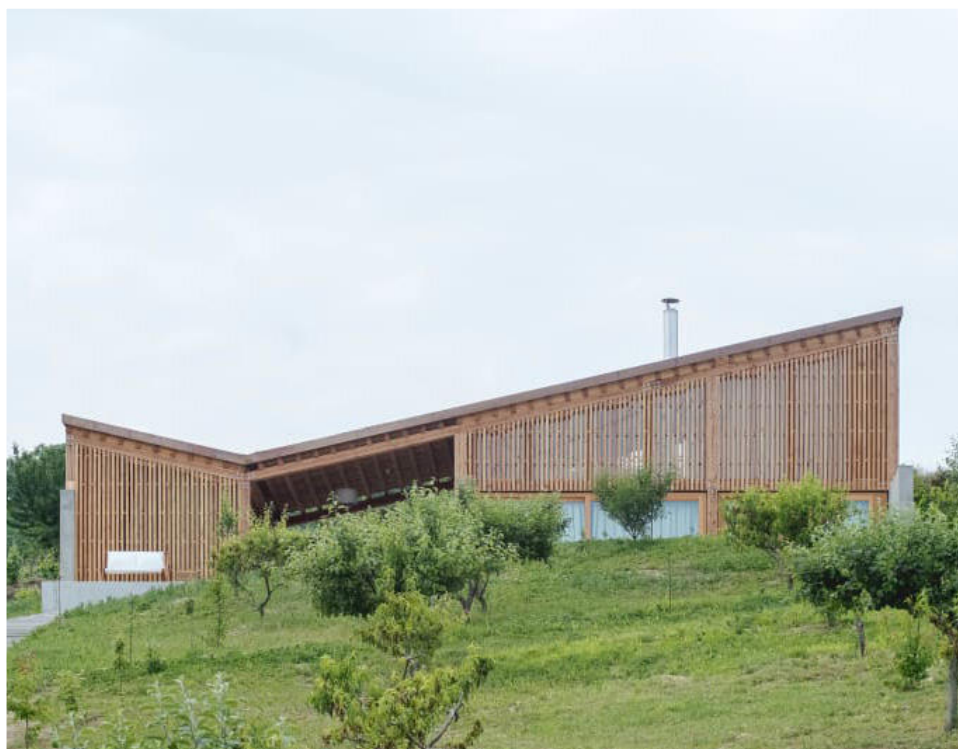
cf : Maisons d'hôte sur exploitation viticole ; Architecte : Epitesz Studio ; Hongrie
