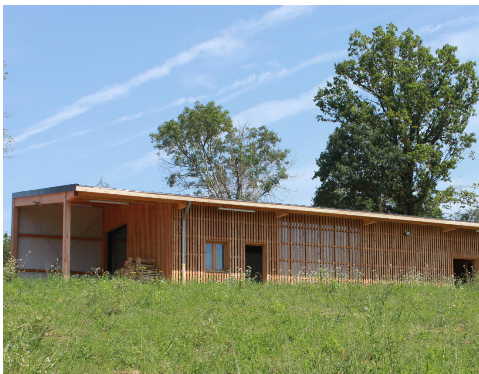
cf : Bâtiment d'exploitation maraîchère ; Architecte : Fabriques ; Neulise (42)
