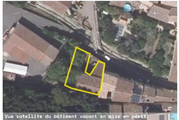
Vue satellite du bâtiment vacant en mise en péril.
